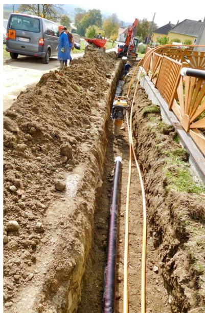
Grabungsarbeiten und Leerrohrverlegung in Dietrichschlag. FOTOS: ING. JOSEF NIMMERVOLL
